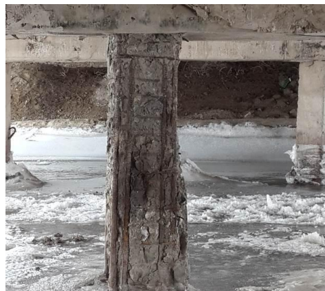
2- расм. Қозиклар ҳимоя қатламининг емирилишидан келиб чиқарадиган бетон ва арматура коррозияси
