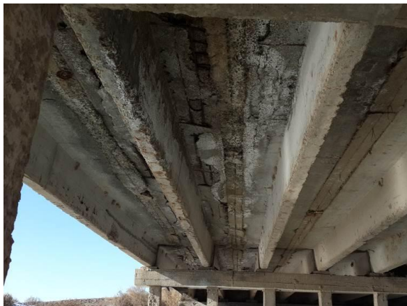
1-расм. Қатнов қисми ва деформацион чоклар орқали сизиб ўтадиган сувнинг фильтрацияси сабабли бетон ва арматура коррозияси ҳамда ҳимоя қатламининг емирилишини
